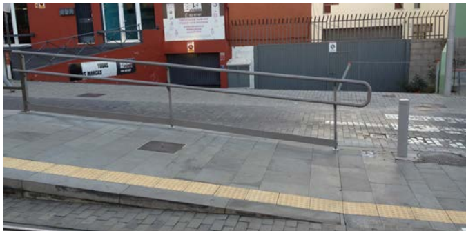
Barandillas en las rampas de acceso a la parada de El Cardonal.
