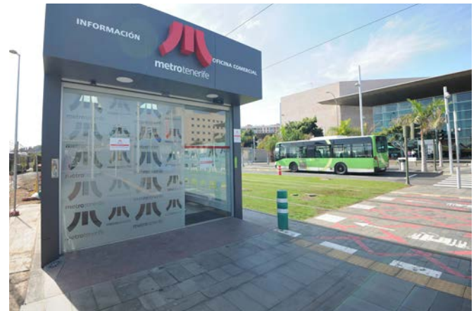
Oficina comercial del Tranvía de Tenerife en la actualidad, en la parada Intercambiador, en Santa Cruz de Tenerife, sin obstáculos para la accesibilidad en su entrada.
